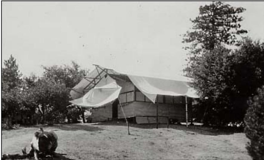
*Abbildung 10: das gleiche Haus mit einer Zeltabdeckung über dem Dach und den Wänden, um die Temperaturen weiter zu stabilisieren.*
